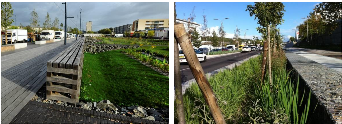
Figure 33 : Exemples de réalisations de voirie avec noues plantées attenantes Source : Banque photo INFRA Services
