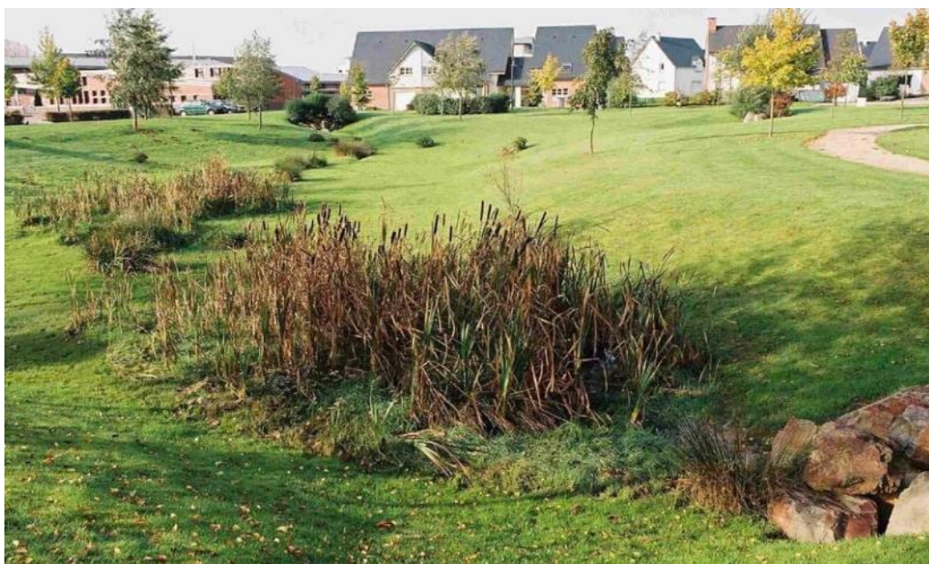
Figure 35 : Exemple de réalisation d'espaces verts creux (1)
