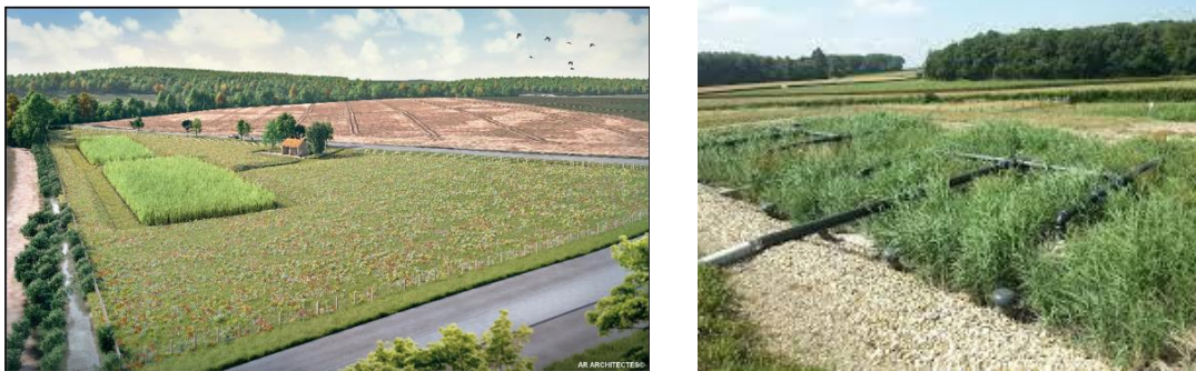
Figure 41 : Exemple de filtres plantés de roseaux
